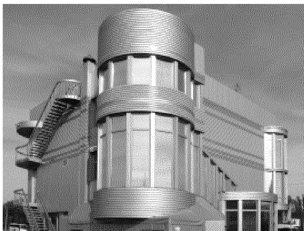
Рисунок 3 – Внешний вид обшивки здания НВФ
