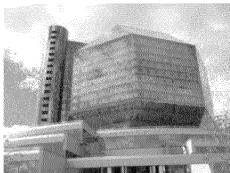
Рисунок 4 – Подвійний фасад будинку. Національна бібліотека Беларусі. Висота 25 поверхів, 72 м. Будівництво 2004 р.
