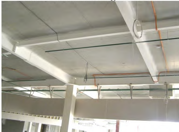
Рисунок 1 - Загальний вигляд фрагмента сталезалізобетонного перекриття
