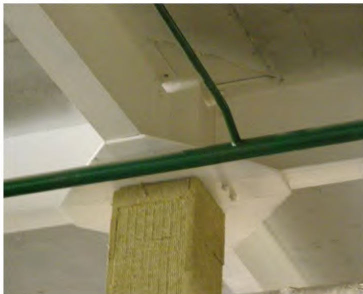
Рисунок 2 - Спирання сталевих балок перекриття на колону
