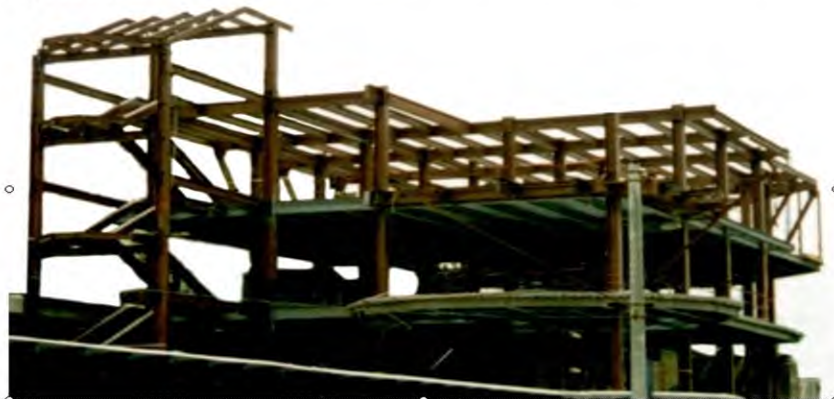
Рисунок 1 - Металевий каркас будівлі касового павільйону
