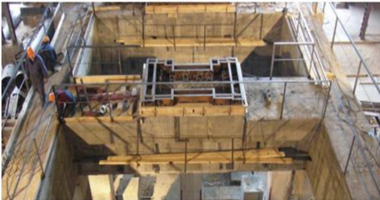
Рисунок 5 – Елементи конструкцій фундаментів турбоагрегатів АЕС
